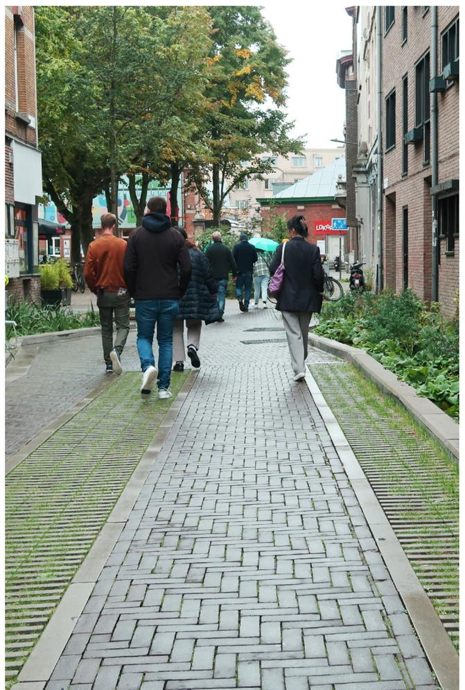
ABB. 64: VERSICKERUNGSFÄHIGE FUSSGÄNGERZONE II (Qu. DTP)
